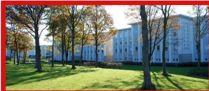
Tagudskiftning, renovering og ombygning, 517 boliger, Esbjerg. Ordre på 100 mio.kr.
