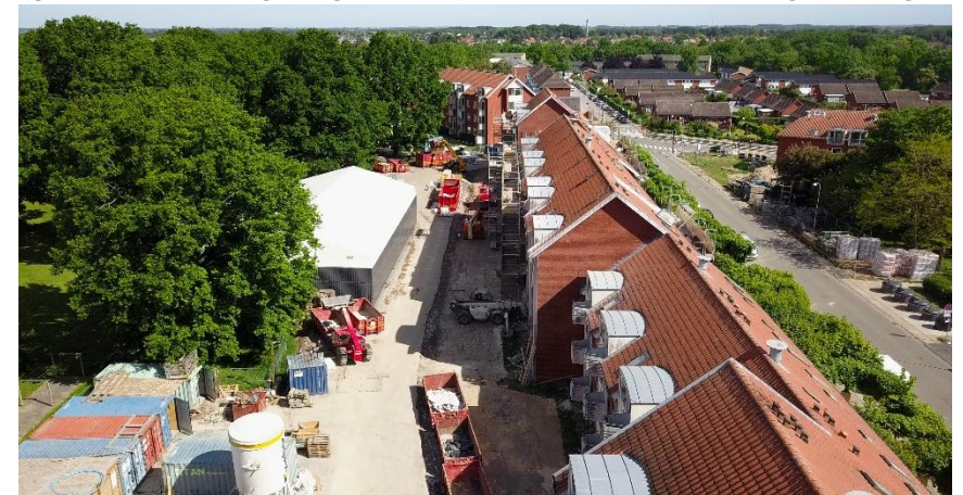
Enemærke & Petersen: Højstrupparken, Odense. Fremtidssikring og totalrenovering af 587 almene boliger i bevaringsværdigt byggeri.
