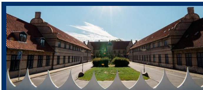
Ombygning af hospital til 231 lejligheder for AAB Aarhus. Ordre på 175 mio. kr.
