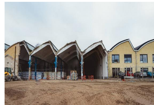
Dalum Papirfabrik: Omdannelse af eksisterende bygningsmasse
