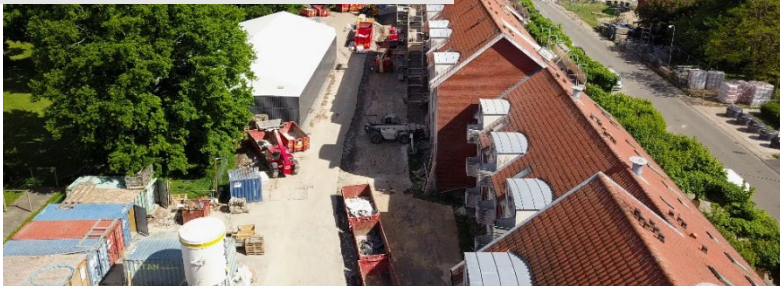
Enemærke & Petersen fremtidssikrer og totalrenoverer 587 almene boliger i Højstrupparken i Odense for FAB.
