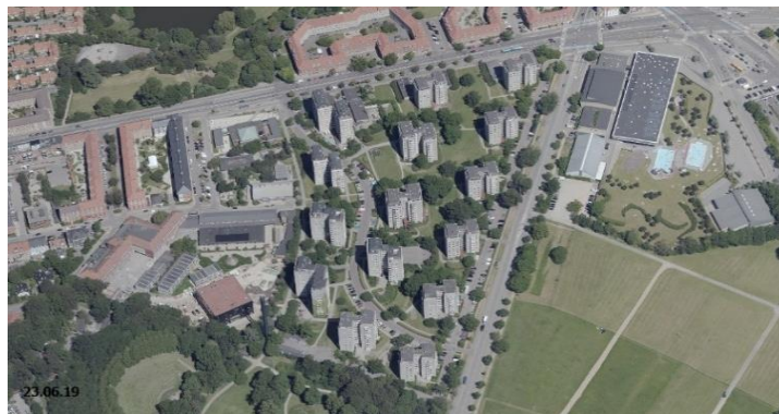
Enemærke & Petersen: Renovering af Bellahøj i Brønshøj for boligselskabet KAB. ~325 mio. kr.
