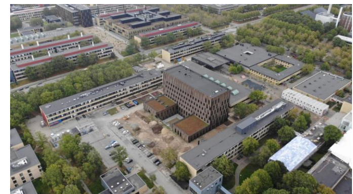
MT Højgaard Danmark opfører fra 2021 Climate Challenge Laboratory-bygning for DTU. ~320 mio. kr.
