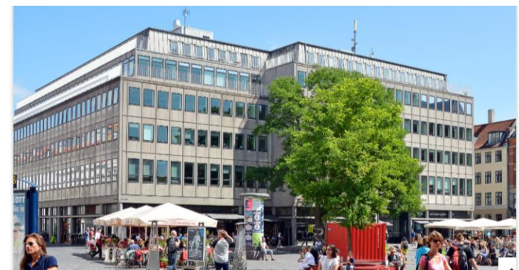
MT Højgaard Danmark: Renovering af Knud Højgaards Hus i København fra 2021. ~180 mio. kr.
