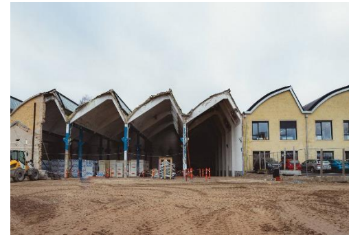
Dalum Papirfabrik: Omdannelse af eksisterende bygningsmasse
