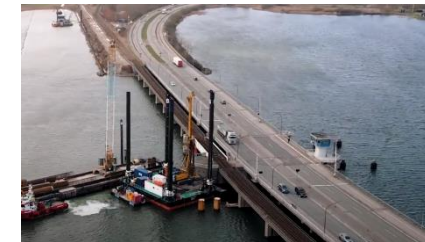
< Ny jack-up under arbejde på Kong Frederik IX's bro
