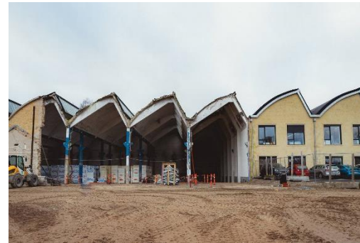
Dalum Papirfabrik: Omdannelse af eksisterende bygningsmasse
