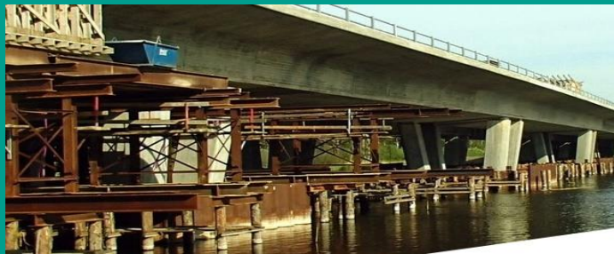
Broer og tunneller
