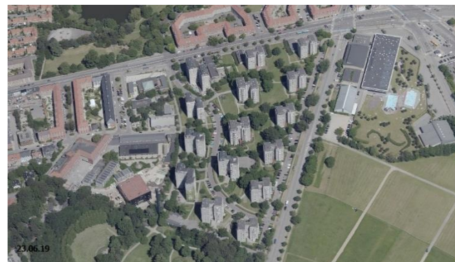
Enemærke & Petersen: Refurbishing of Bellahøj in Brønshøj for housing association KAB. DKK 325 million.
