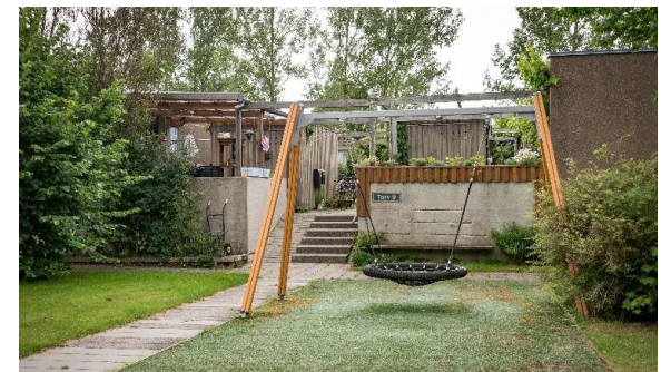
Enemærke & Petersen: Renovering af boligkvarteret Galgebakken. 1,1 mia. kr.
